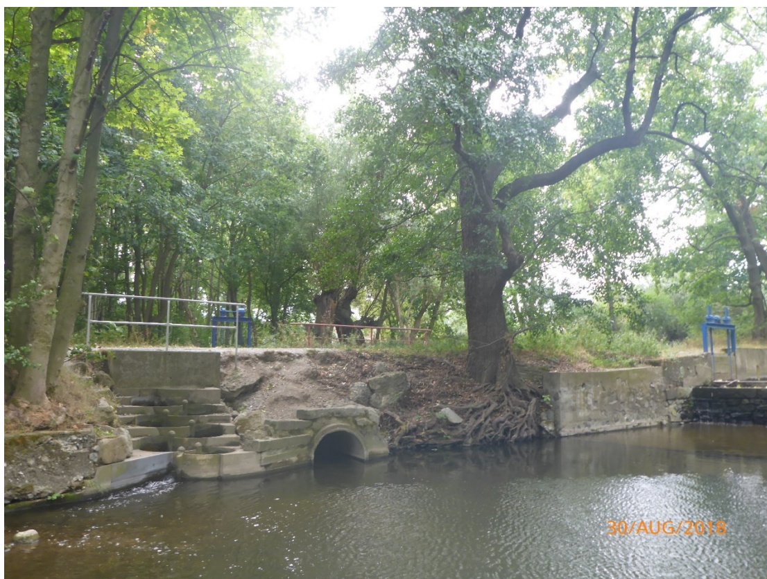
Abb. 50: Holtemme im UR südlich der BAB 36, Wehranlage mit Fischaufstiegsanlage
