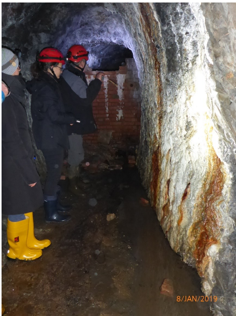
Abb. 13: Stollen Luisental, Ortsbesichtigung 08.01.2019
