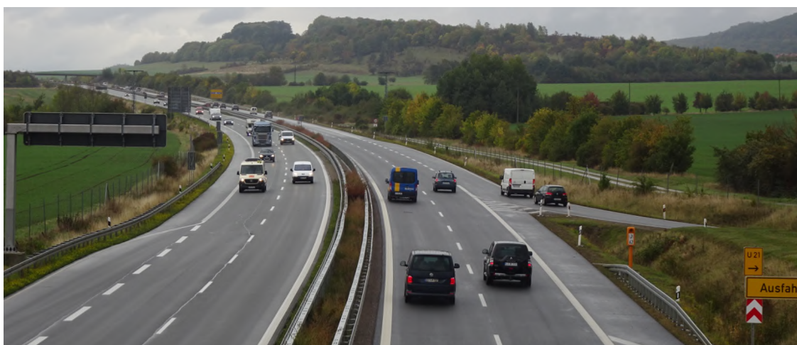
Blick von der AS Wernigerode-Zentrum nach Osten
